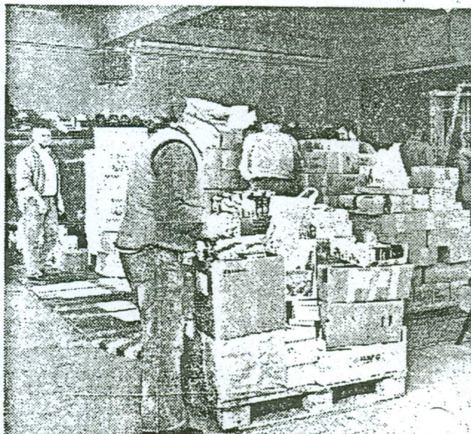
LEBENSMITTELLAGER im Feuerwehrgerätehaus von Zimmersrode. Die „Schätze“ werden gesichtet und verladen.
